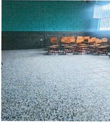
Foto 1: colocación de 275 m2 de piso de granito
