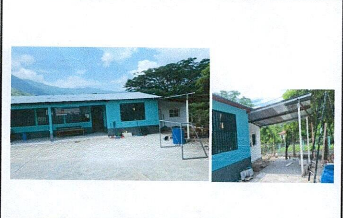
Foto 11: Mejoramiento de techo de la escuela, cambio de lámina en área de Dirección, cocina y área de comedor
