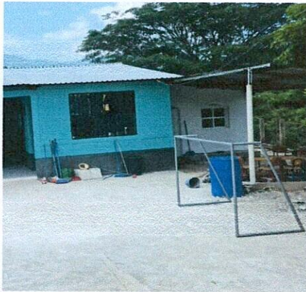
Foto 3: Remozamiento del área de cocina y área de comedor
