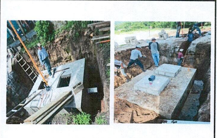
Foto 12: Construcción de nueva de fosa séptica
